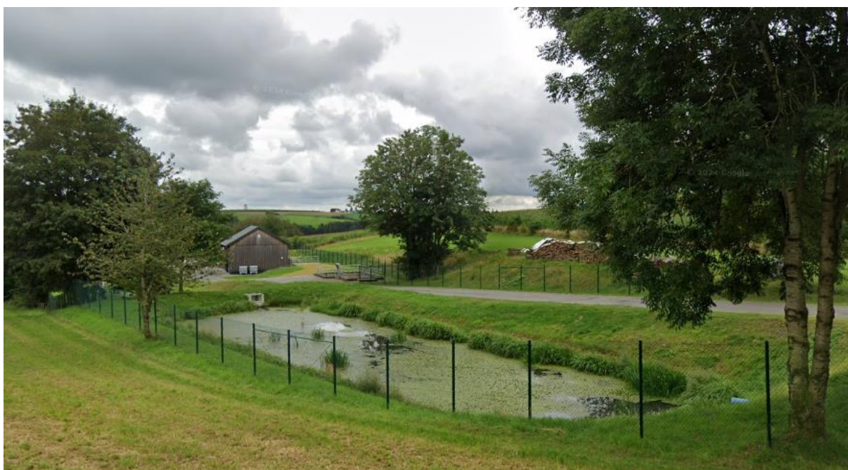
Abbildung 8: Blick von Süden nach Südosten auf die biologische Kläranlage von Hoscheid-Dickt. Quelle: Oeko-Bureau, August 2024.
