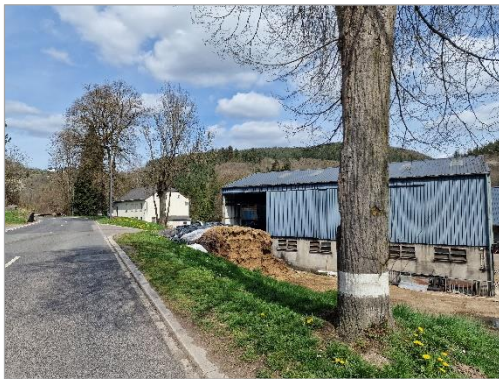
Blick 3 auf die bestehende Straßentrasse im Süden
