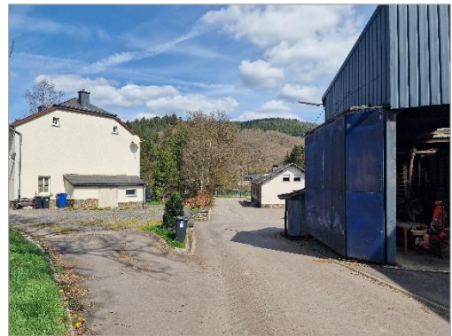
Blick 4 auf die bestehende Straßentrasse im Süden
