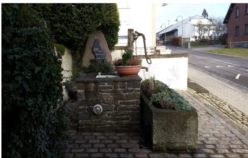
Figure 19 : Puits avec pompe à eaux manuelle (Source : BEST)
