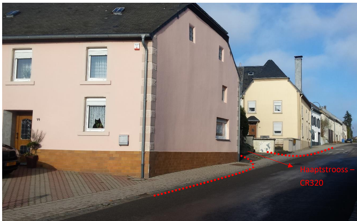
Figure 18 : Raccordement voirie (Source : BEST)
