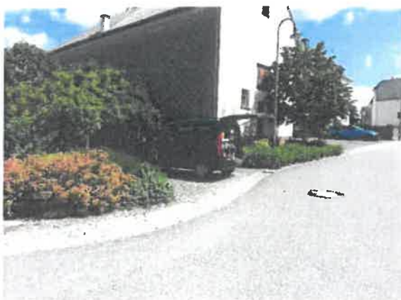
Photo 1 : Vue sur le bâtiment existant (Source : BEST)
