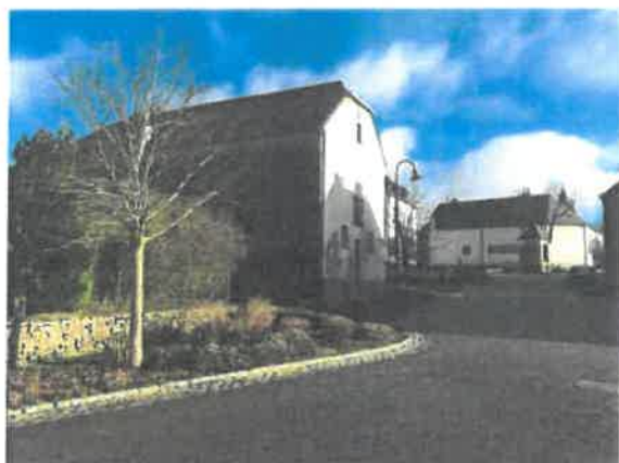
Photo 3 : Vue sur la rue « Kraeizgaass » (Source : BEST)
