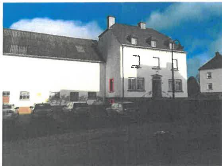
Figure 13 : fenêtres latérales du lot 1 (source : BEST)
