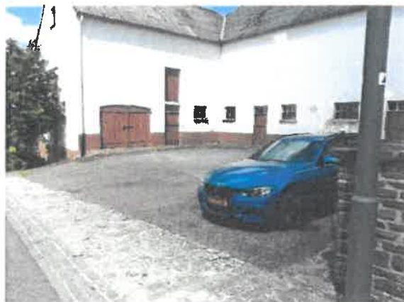
Photo 2 : Vue sur la cours intérieure de la ferme (Source : BEST)
