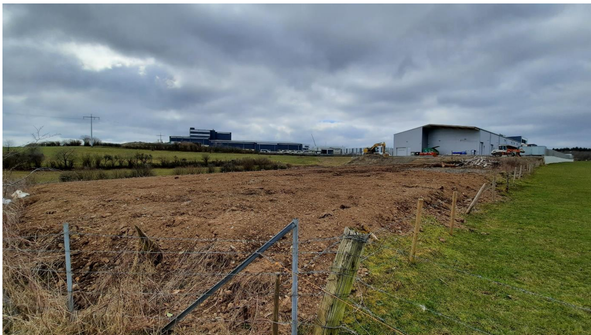
Abbildung 18: Ehemaliges Betriebsgelände im Süden. Quelle: Oeko-Bureau 2021
