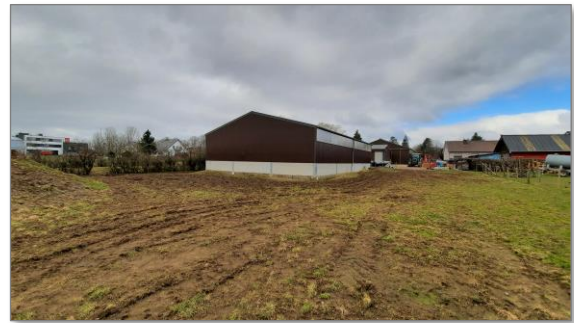
Abbildung 17: Blick 5 Richtung angrenzende Bestandsbebauung
