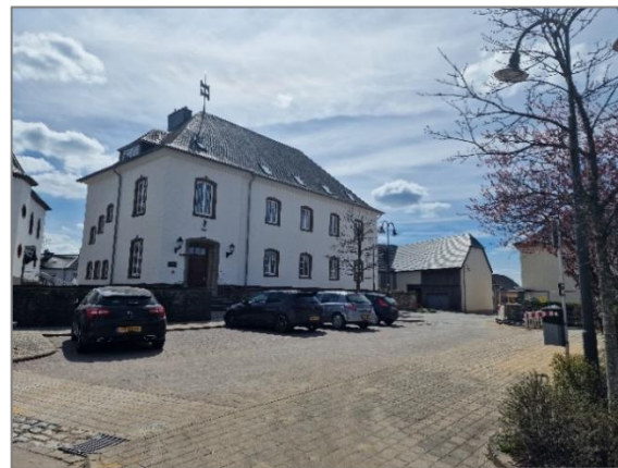
Abbildung 8: Blick 6 von Südosten auf die „Kraeizgaass“
