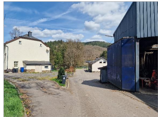
Blick 4 auf die bestehende Straßentrasse im Süden
