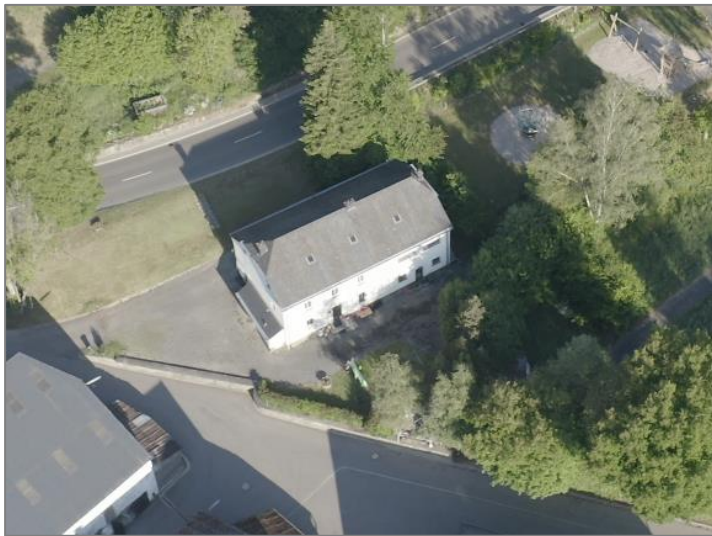
Abbildung 5: Kommunal denkmalgeschütztes Gebäude in 3, Hauptstrooss
