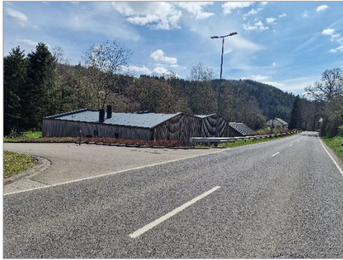
Blick 1 auf die Zufahrt zum Kulturzentrum
