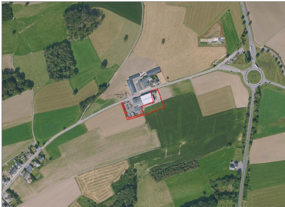
Abbildung 1: Luftbild des Ortseingangs der Ortschaft Holzthum mit Abgrenzung des Plangebietes (rot). Quelle: Orthophoto 2021, verändert nach CO3 2022
